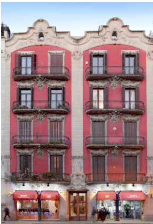
Fig.5. Façana del Museu del Modernisme de Barcelona.
