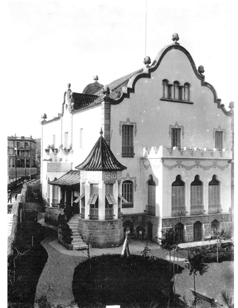
Fig. 5 Fachada interior con vistas al jardín y a las cocheras. De izquierda a derecha: terraza, glorieta y galería.
